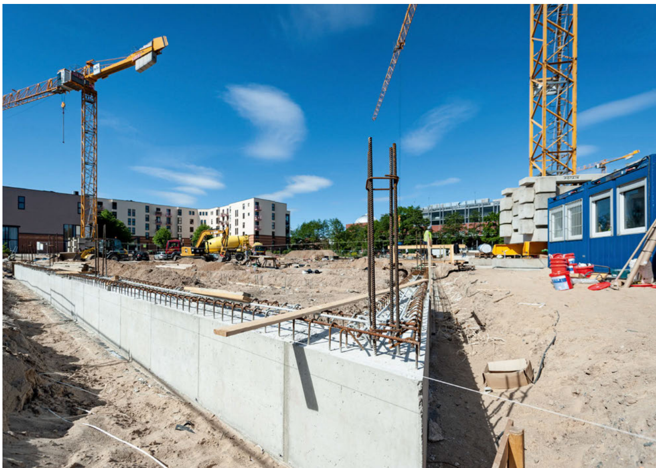
Die Hochbauphase hat begonnen: die Baustelle des KörberHauses im Juni 2020
